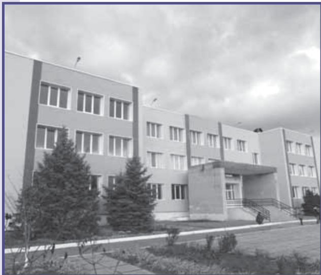
Реконструйована будівля СШ №19 у м. Павлограді
