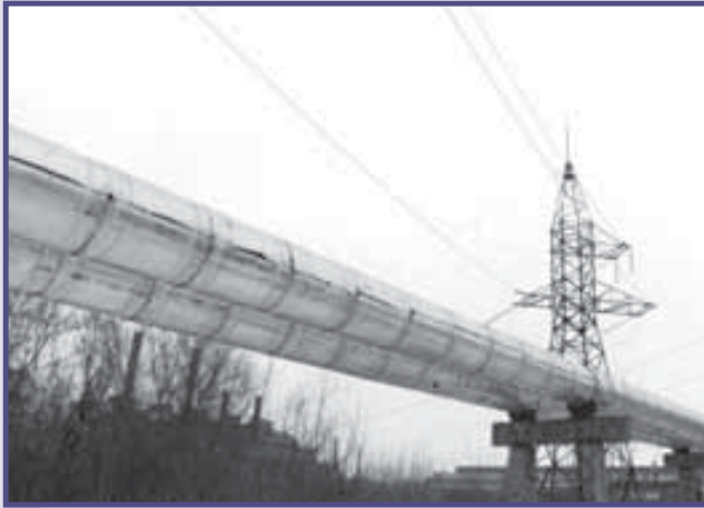
Замінений магістральний трубопровід 3-ої зони тепlopостачання
