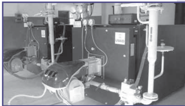
Заміна мазутного котла на газовий на котельні по вул. Тучина 1/2.
